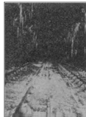
Abb. 5. Durch schweflige Säure aus Rauchgasen beschädigte Tunneldecke.
